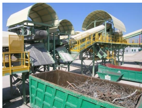
Μονάδα ανακύκλωσης αποβλήτων Κ&Κ. Πηγή: ANPAR
