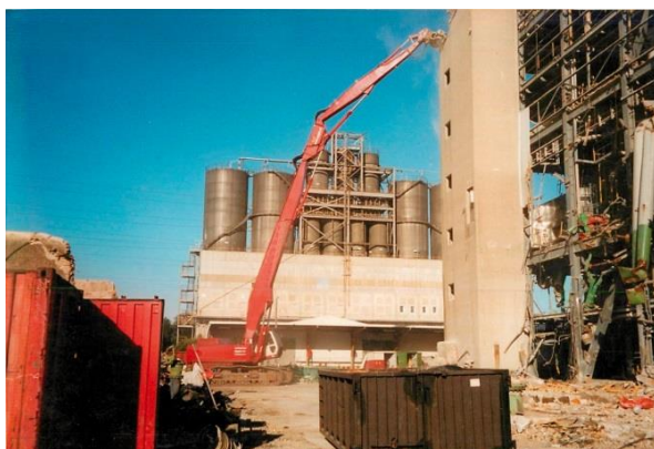
Εργοτάξιο κατεδάφισης. Πηγή: VERAS
